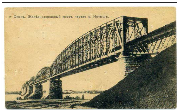
Омск. Железнодорожный мост через Иртыш. (Старая открытка)
