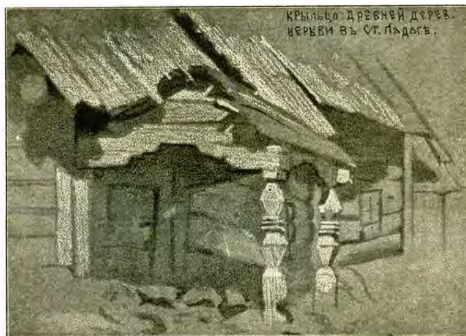
Крыльцо древней дер. церкви в Ст. Ладоге (рис. Н.К. Рериха).
