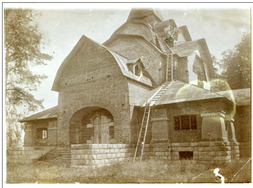
Строительство храма Св. Духа во Флёново. 1911 г. (Фото из архива Н.К. Рериха: ОР ГТГ, ф.44/1694.)
