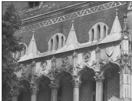
Деталь фасада эклектического сооружения. Венгрия. Начало XX в.
