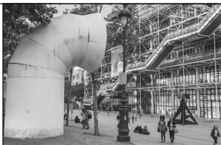
Вентиляционные трубы и часть фасада Центра Жоржа Помпиду. Ричард Роджерс. Париж, Франция. 1977 г.
